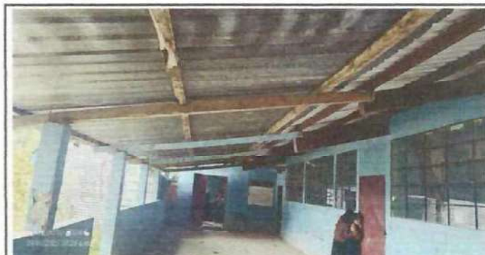
Foto 4: SUSTITUCION DE ESTRUCTURA DE MADERA POR ESTRUCTURA DE METAL EN EL CORREDOR DE LA ESCUELA. 24X5 METROS CUADRADO.
