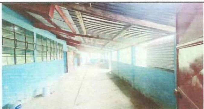
Foto 3: SUSTITUCION DE PISO DE CORREDOR 24 X 5 METROS CUADRADO.
