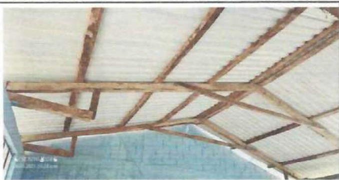
Foto1:MODULO 1 SUSTITUCION DE ESTRUCTURA DE MADERA POR ESTRUCTRA DE METAL E INSTALACION DE LAMINAS NUEVAS 7X 6.65.
